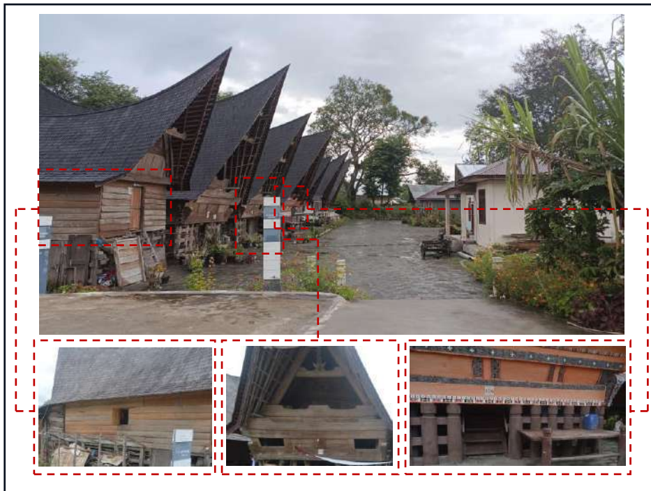
Gambar 5.43 Analisa flamabilitas material bangunan massa blok utara
