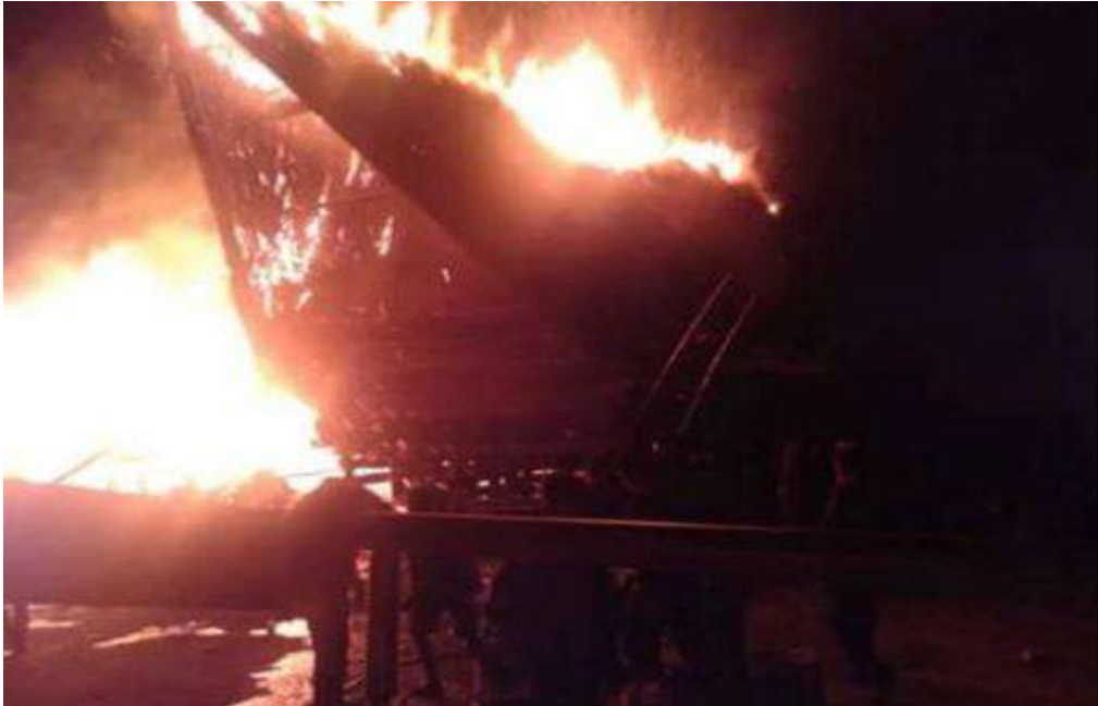
Kondisi Rumah adat saat terbakar di Dusun II, Desa Aek Nauli Kecamatan Pangururan, Kabupaten Samosir, Jumat (20/9/2019) dini hari Sumber :Tribun Medan, September 2019
