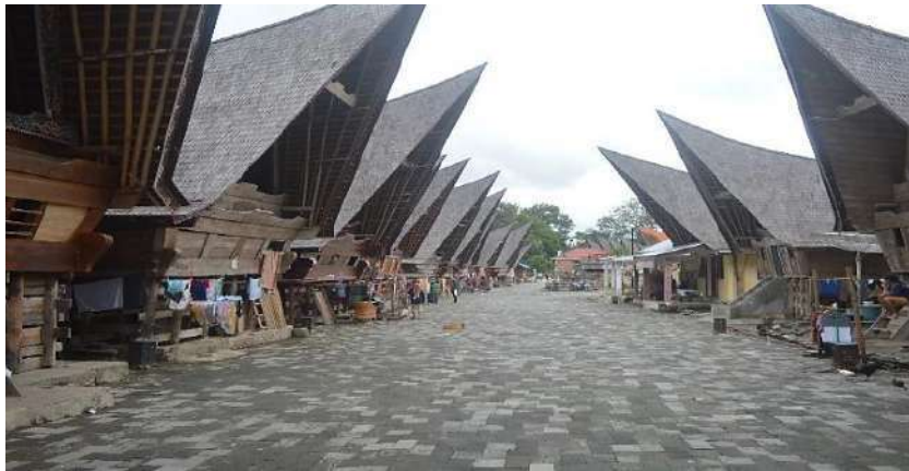
Ruang Terbuka Area Selatan
