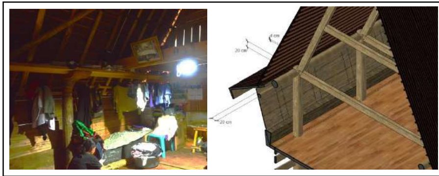
Gambar 5.31 Analisa integritas struktur balok dan rangka atap
