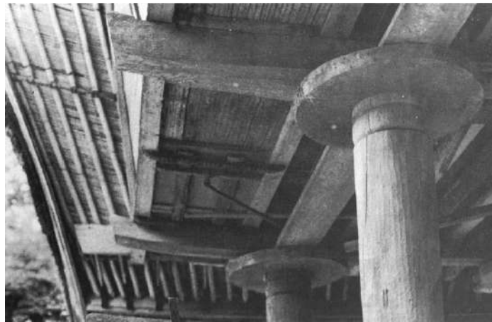
Struktur Tiang dan Balok Lantai
