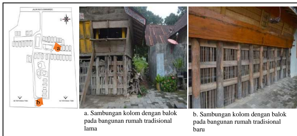
Gambar 4.39 Sambungan kolom dengan balok pada bangunan rumah tradisional lama (kiri) dan rumah tradisional baru (kanan)
